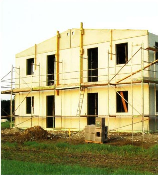
Am 08.09.2006 wurde die 350m<sup>2</sup> (25m x 14m) große Bodenplatte betoniert und innerhalb von nur drei Wochen der komplette Rohbau fertiggestellt: 2.100m<sup>3</sup> umbauter Raum (zum Vergleich: Einfamilienhaus: ca. 800m<sup>3</sup>).
