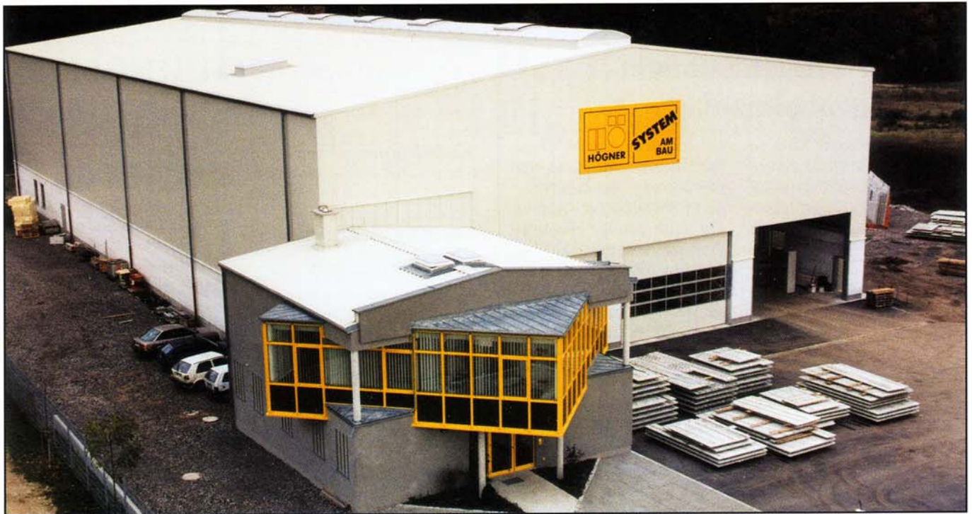
Ohne Schwierigkeiten könnten zwei ganze City-Jets in dieser Halle stehen. Und ihre High-Tech wäre bei der unsrigen durchaus in bester Gesellschaft!
